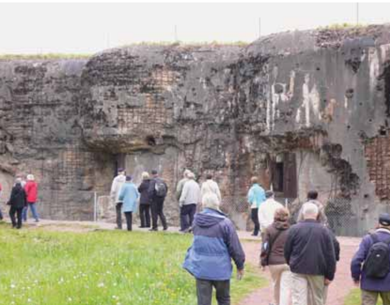
Jyhkeää rakennelmaa. Kuva Risto Jääskeläinen
